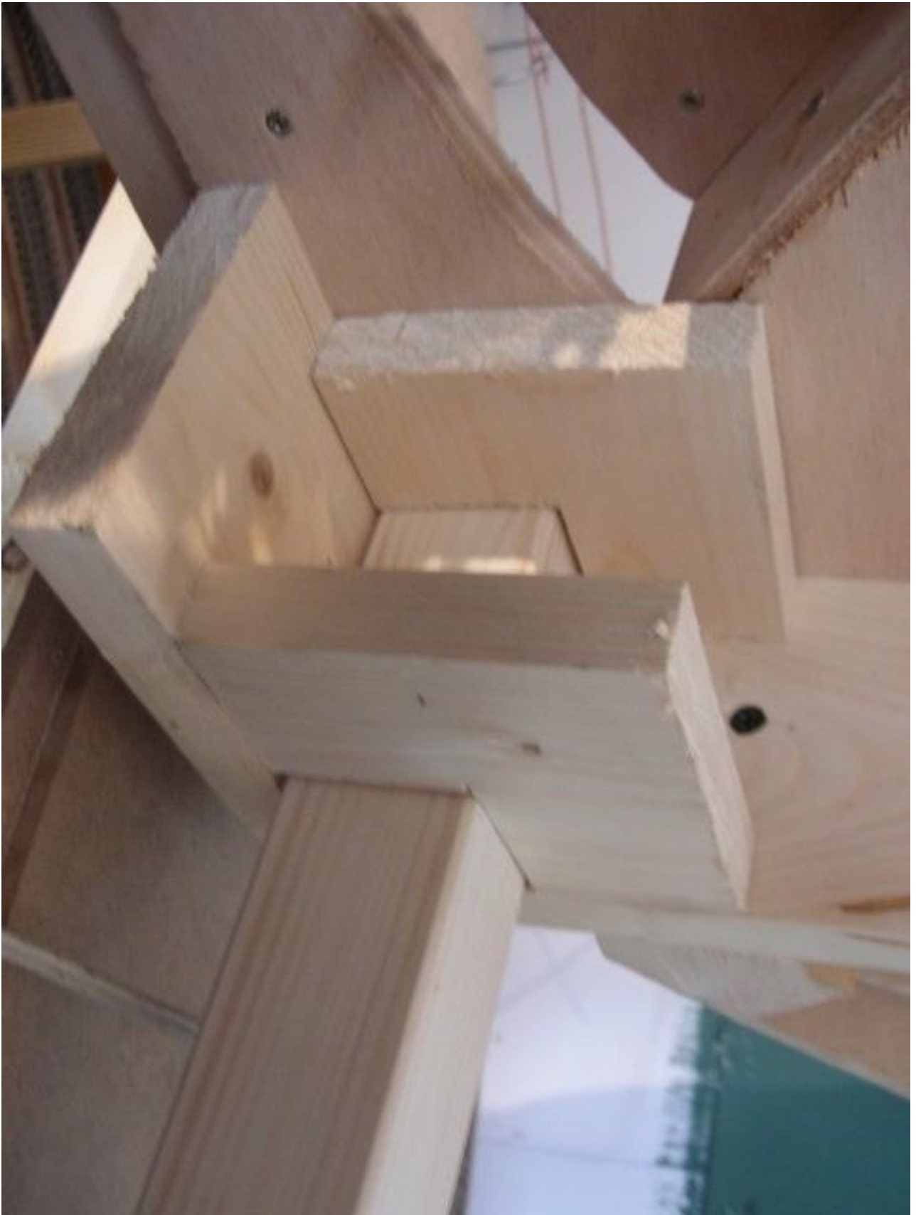
Voorbeeld hoe een poot in de module is bevestigd.
